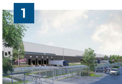
1 Bain-de-Bretagne (35), près de Rennes pour Dimolog, un nouveau client (30 000 m 2 )
